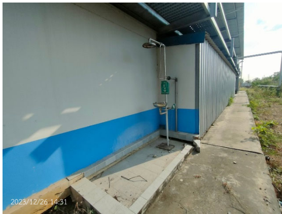
ติดตั้งชุดล้างตัวและล้างตาฉุกเฉิน (Emergency Eyewash and Shower) ไว้บริเวณด้านหลังอาคารคอมเพล็กซ์
