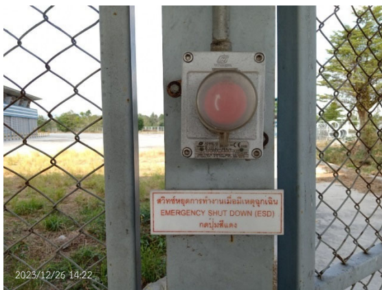
ติดตั้งระบบสัญญาณแจ้งเตือนเมื่อเกิดเหตุฉุกเฉิน
